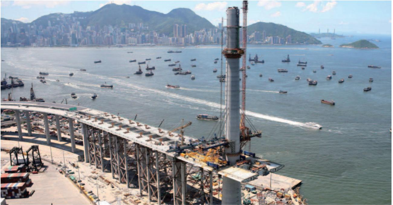
〈ストーンカッターズ橋〉青衣島と昂船州を結ぶ全長約1,596m、主塔高さ298mの斜張橋
